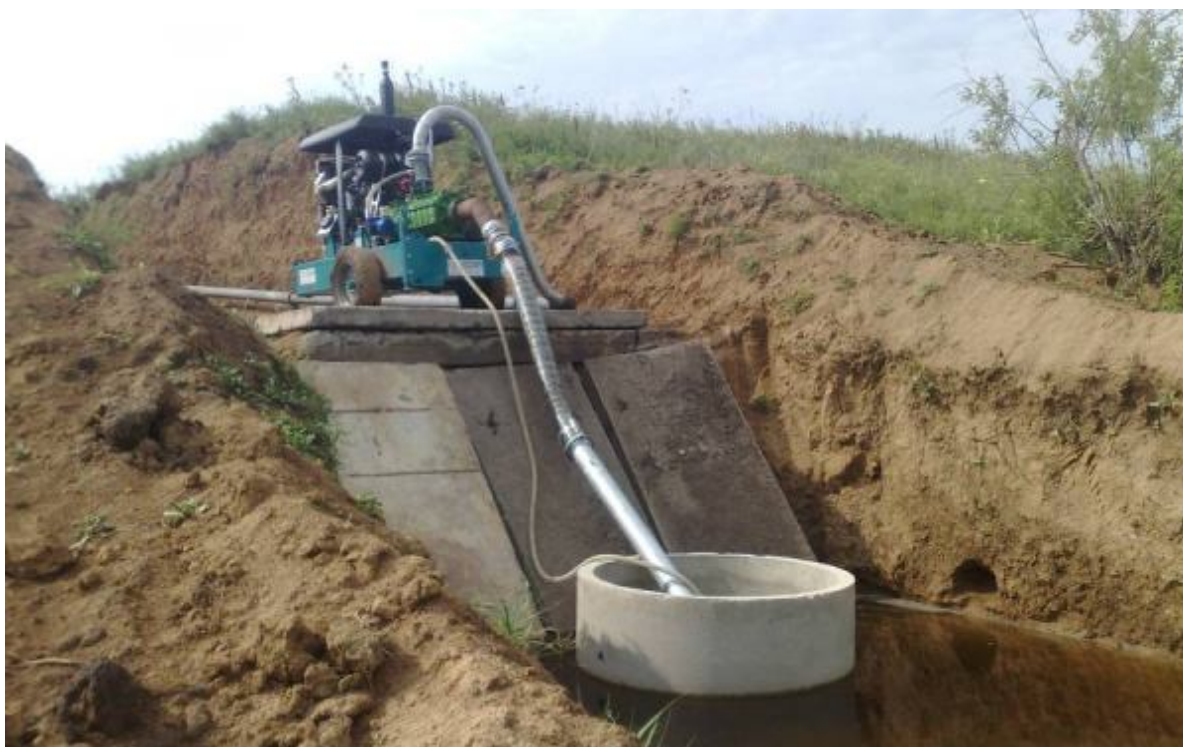
Рис. 3.10. Водозабор передвижной насосной станцией компании «SCOVA»
